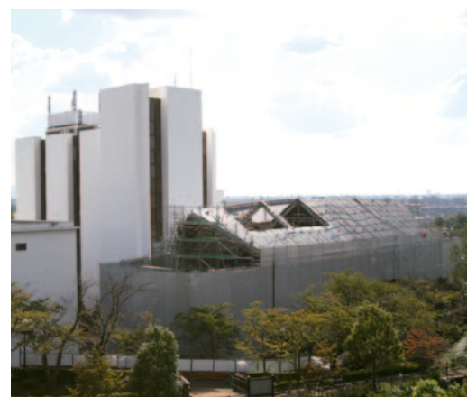
建物をシートで覆い、サッシ・外壁工事を行っています。 屋根の部分も出来上がりつつあります（10月6日現在）。
