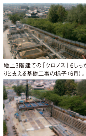
建物の骨組みとなる鉄骨が運び込まれ、西側エリアから柱が立ち上げられています（7月）。
